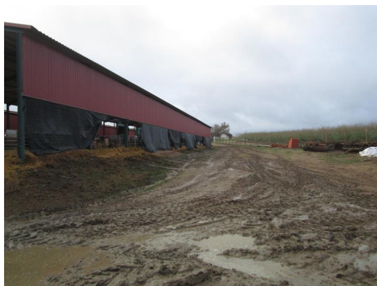
Figura 7.58 – Núcleo Sul: vista geral das infraestruturas de apoio (solo artificializado)
