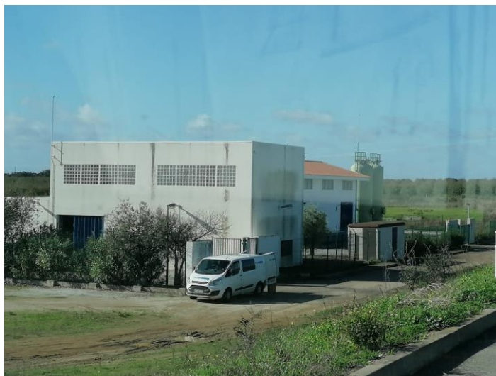
Figura 7.52 – Estação Elevatória pertencente à EDIA
