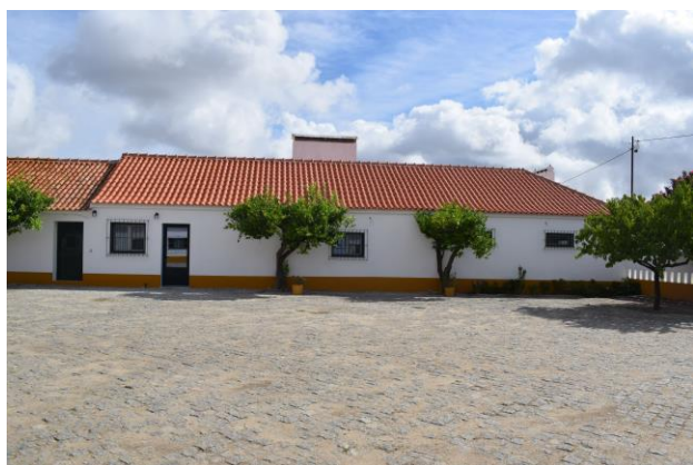
Figura 6.1 – Vista para o Edifício 1 da Parcela 1 – Monte do Gavião
