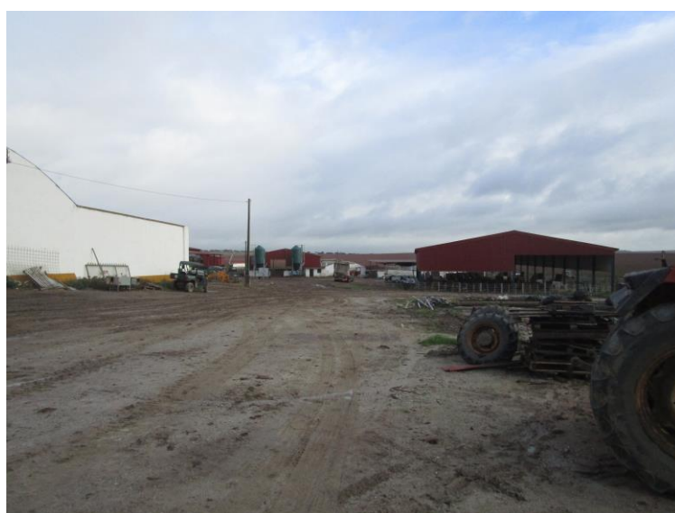
Figura 7.55 – Núcleo Sul: vista geral das infraestruturas de apoio (solo artificializado)
