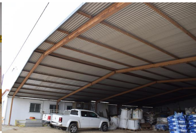
Figura 6.10 – Zona do telheiro - Arrumos
