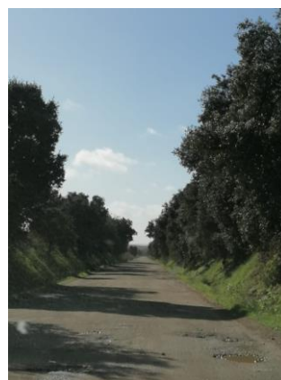
Figura 7.54 – Estrada Municipal – M 534 – que permite o acesso à parcela 2 em estudo
